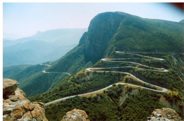
figura 1.4. Tipo de relevo de uma região ( h é a diferença de altitude entre máximos e mínimos consecutivos). Exemplos de estradas acompanhando a topografia (terreno ondulado e terreno montanhoso)
