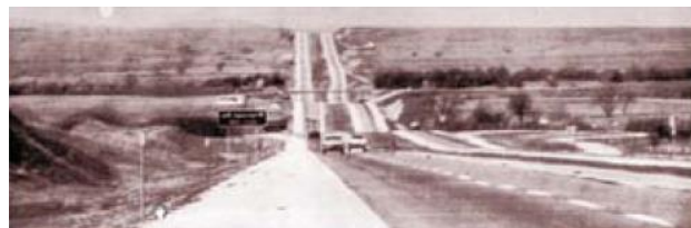
figura 1.114. Trainéis longos ligados por curvas verticais de pequeno raio produzem um mau efeito visual: tornar as curvas horizontais e verticais coincidentes
