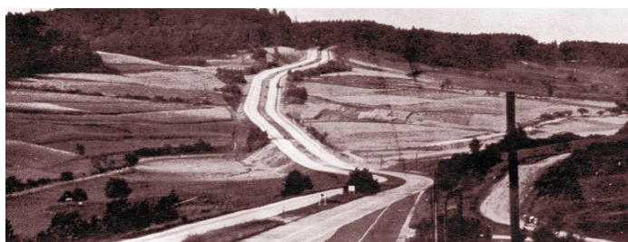
figura 1.115. Estrada mal ajustada ao terreno devido à utilização de tangentes longas ligadas por curvas horizontais de pequeno raio
