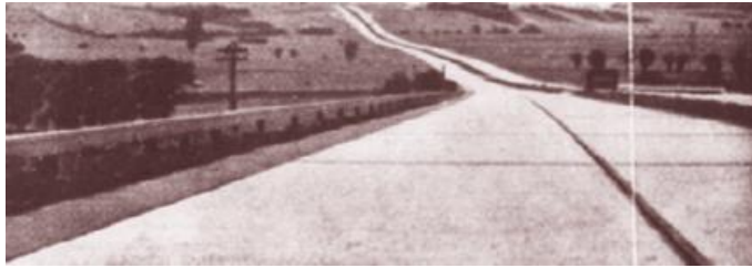
figura 1.112. Exemplo de efeito óptico causado por uma curva horizontal numa depressão: ajustar ambas as curvas
