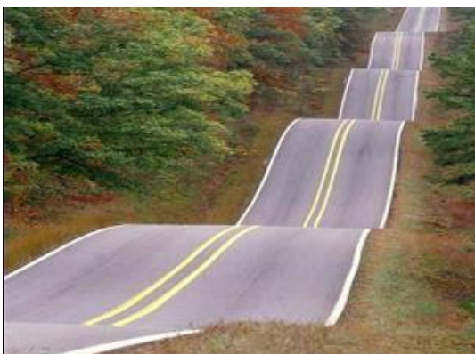
figura 1.4. Tipo de relevo de uma região ( h é a diferença de altitude entre máximos e mínimos consecutivos). Exemplos de estradas acompanhando a topografia (terreno ondulado e terreno montanhoso)
